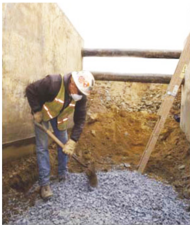
Caja de protección y escala
