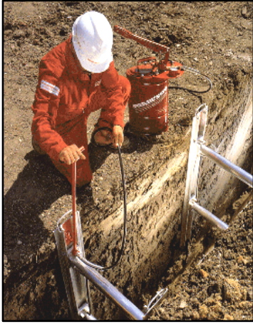
Inspección de los sistemas de protección
