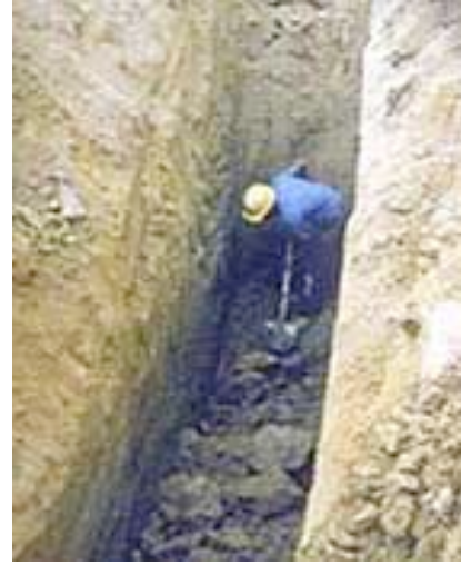
No hay Protecciones laterales
