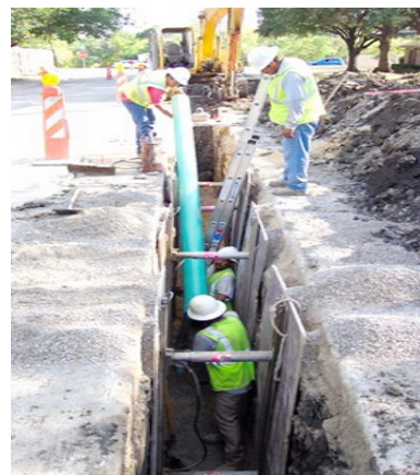
Sistemas de protección, escalas y ropa de alta visibilidad
